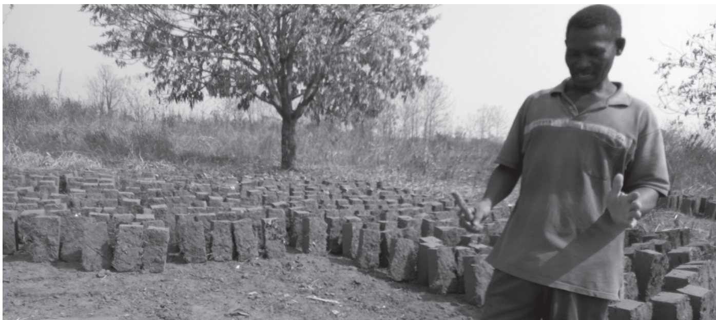
Un maçon de Damadé produisant des briques en terre crue
